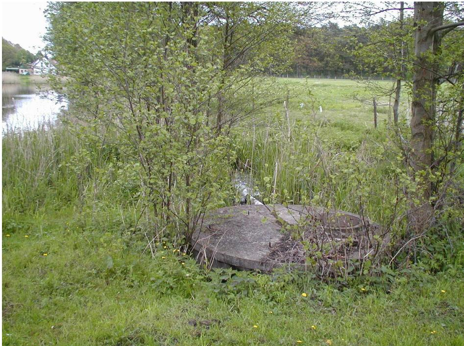
Abbildung 11: Nonnenfließ, verrohrter Zufluss in den Lambs-See, soll rückgebaut und naturnah gestaltet werden (weitere Bilder zum Projekt Nonnenfließ auf S. 16 und S.36)
